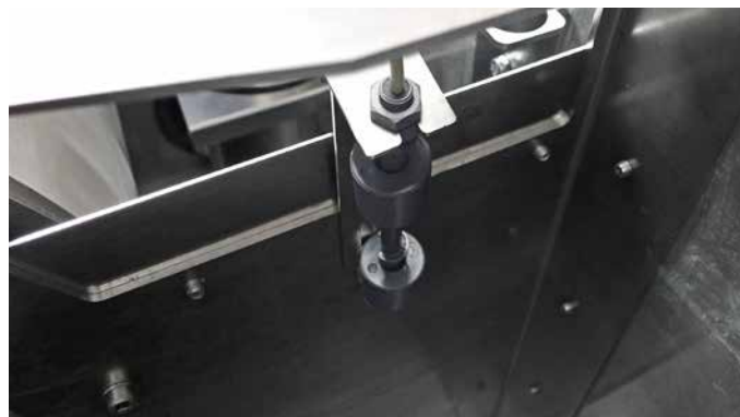
Partie des eaux usées devant le tambour
