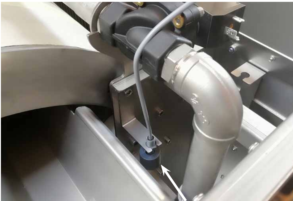
Montage de l'interrupteur flottant 1 dans la zone à droite de la préchambre sous l'électrovanne
